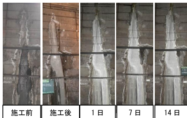
図-3 施工結果(止水工②)
