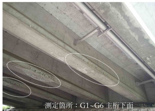
図 3-6 超音波法測定位置
