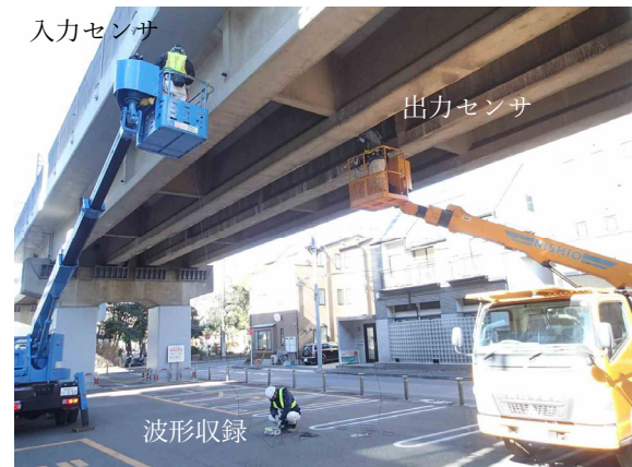
図 7-8 打音振動法の測定状況
