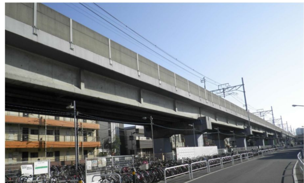
図 7-1 東西線既設ポステン T 桁橋の全景
