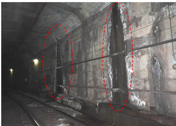
図-1 トンネル漏水部
