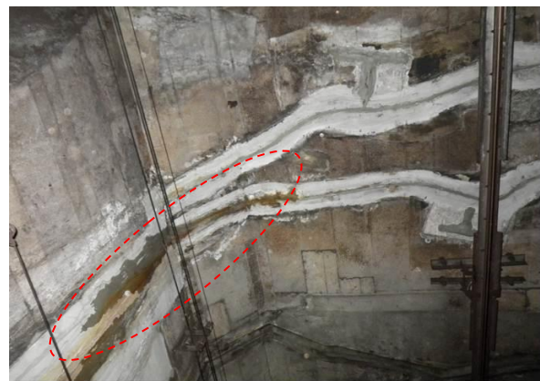
図-2 再漏水箇所
