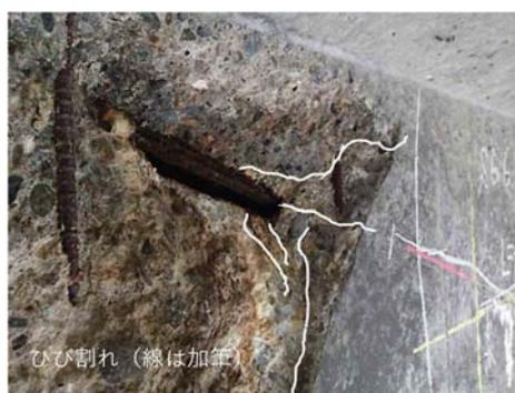
図-10 実橋のひび割れ発生状況
