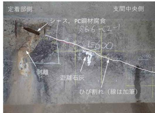
(a) PC 桁のひび割れ状況 (C2 ケーブル終点側)
