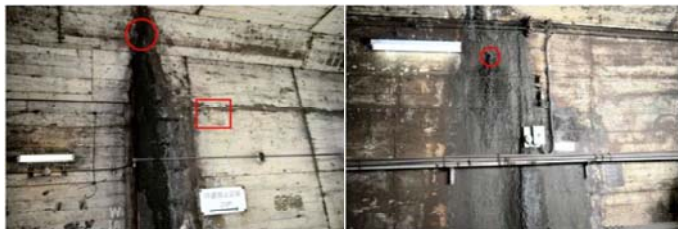
(a)新規漏水箇所
