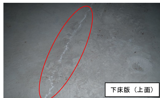
図-5 下床版 (上面) の目地開き
