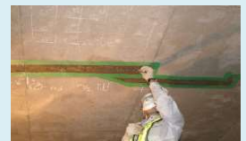
ひび割れ充填
