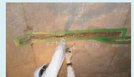
反応制御材を塗布
