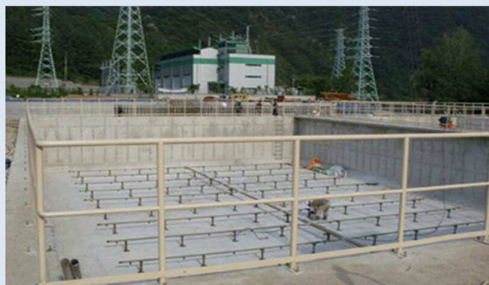
廃水処理施設
