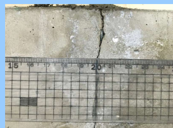
2) ひび割れ幅の確認
