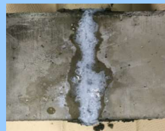
7) ひび割れ部分補修完了
