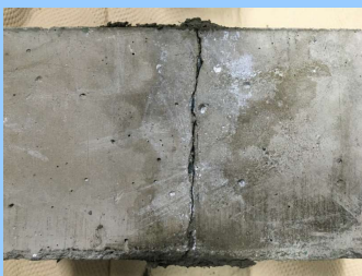
1) ひび割れ部分の掃除 (Air使用、粉塵の除去)
