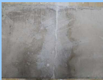
9) 表面掃除(補修完了)
