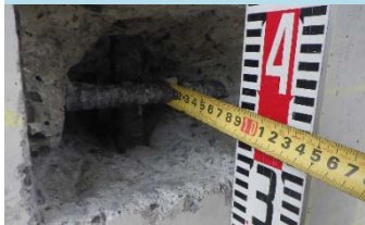
鉄筋腐食状況状況
