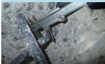
鉄筋かぶり測定
