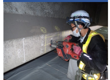
コンクリート粉採取状況
